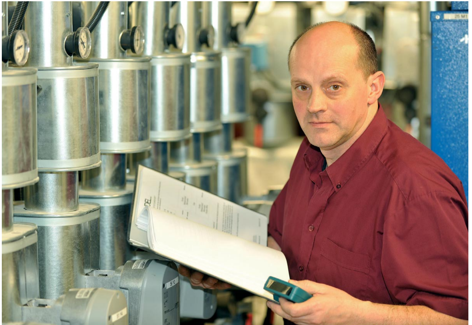
ANDREAS ELDERS im Technikraum im Keller des Museums. Hier steht die Geothermie-Anlage, die das StiftsMuseum sowohl mit Wärme als auch mit Kühlung versorgt.
