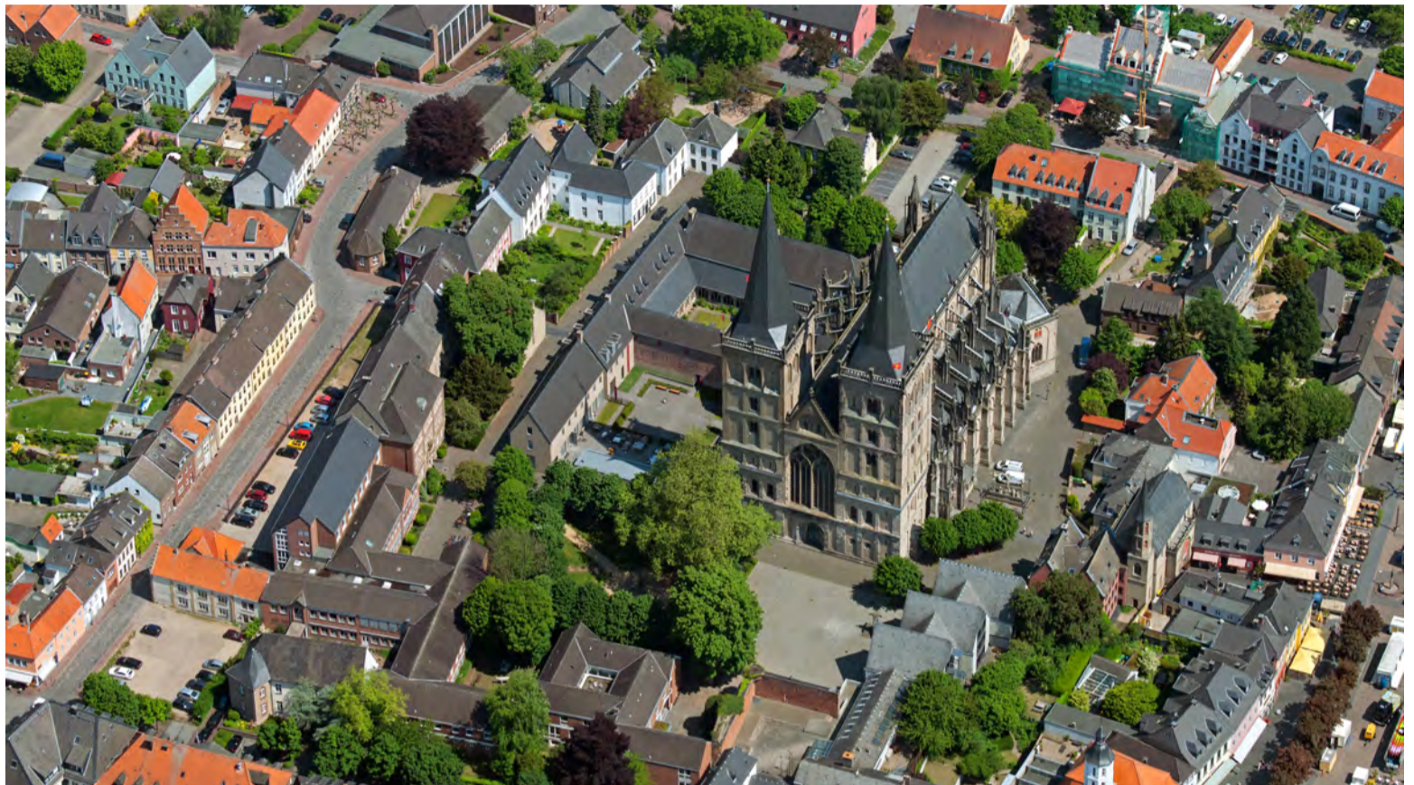
Dom und StiftsMuseum Xanten aus der Luft. Gut zu erkennen ist die einstige Begrenzung des Stifts-Gebietes durch die ringförmige Bebauung.
